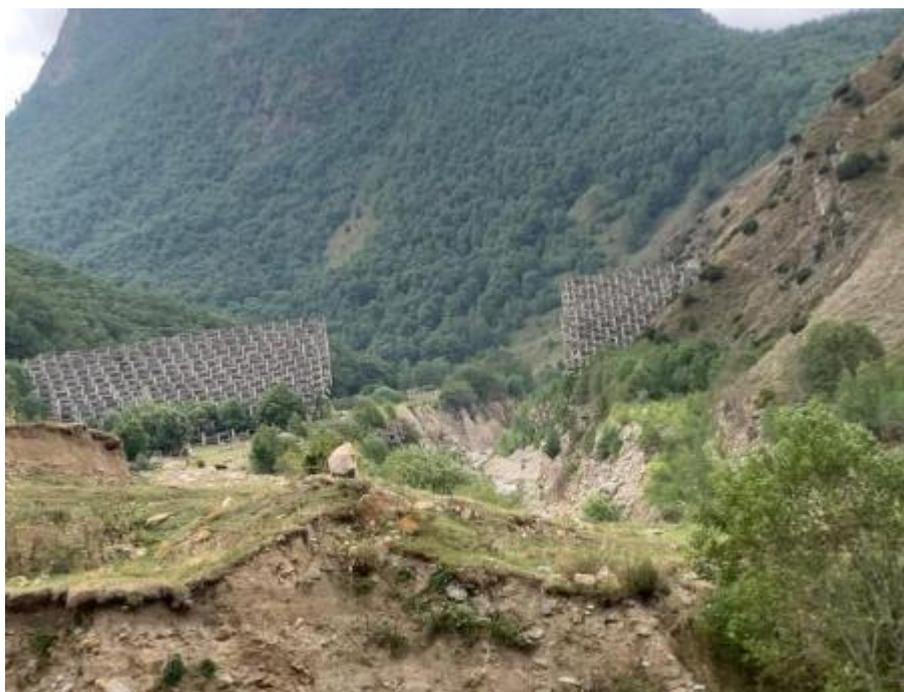
Рисунок 3.14. Разрушенная селеудерживающая плотина. Фотография автора, 2021 год.
