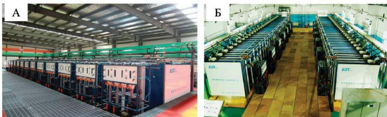
Рисунок 1.27. Крупномасштабные модули опреснения ЕД производства группы компаний EST, Китай: (А) опреснительная установка для очистки и повторного использования муниципальных сточных вод производительностью 60000 м<sup>3</sup> в сутки и (Б) завод по очистке сточных вод угольных шахт производительностью 5000 м<sup>3</sup> в сутки [120]
