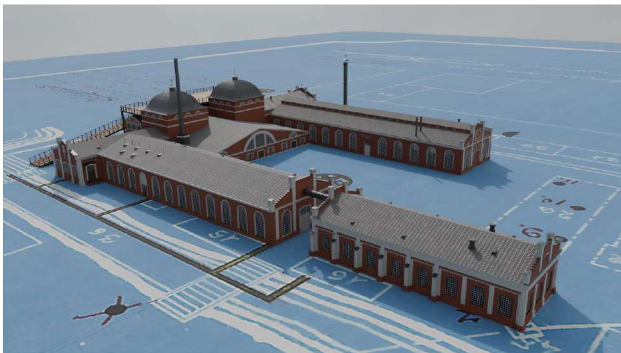
Рис. 13. Финальные рендеры строений Баранчинского завода. Реконструированы корпуса литейной и механической фабрик, доменных печей и доменного двора, ваграночного корпуса, корпуса паровой машины, здание турбины Жирарда, здание машины Каупера. Рендер из ПО Blender при использовании алгоритма рендеринга «Cycles».
