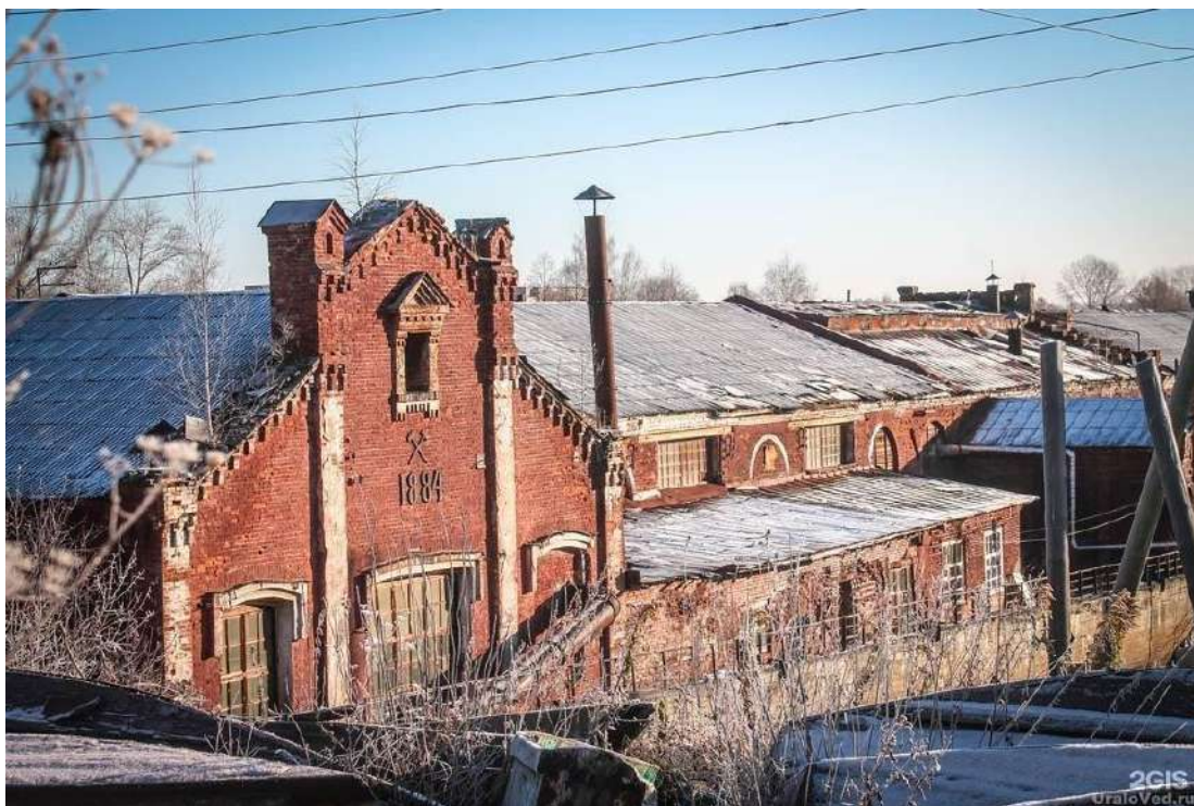
Рис. 43. Фотография из сети Интернет, сделанная предположительно в 1990-е – начало 2000-х гг. Можно увидеть здание паровой машины и частично разрушившийся, частично перестроенный корпус механической фабрики. Неизвестно, когда именно эти постройки были полностью утрачены, однако спутниковая съемка не дает сомневаться в этом печальном факте.
