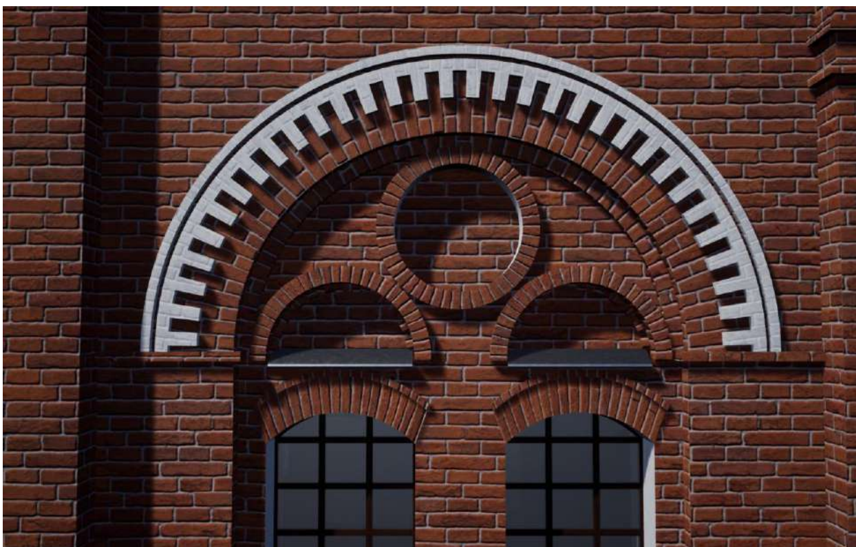
Рис. 12. Пример корректного отображения кирпичной кладки на элементах декора, соответствующего данным источников. Для достижения такого эффекта использовалось создание UV-разверток для данных элементов «вручную».
