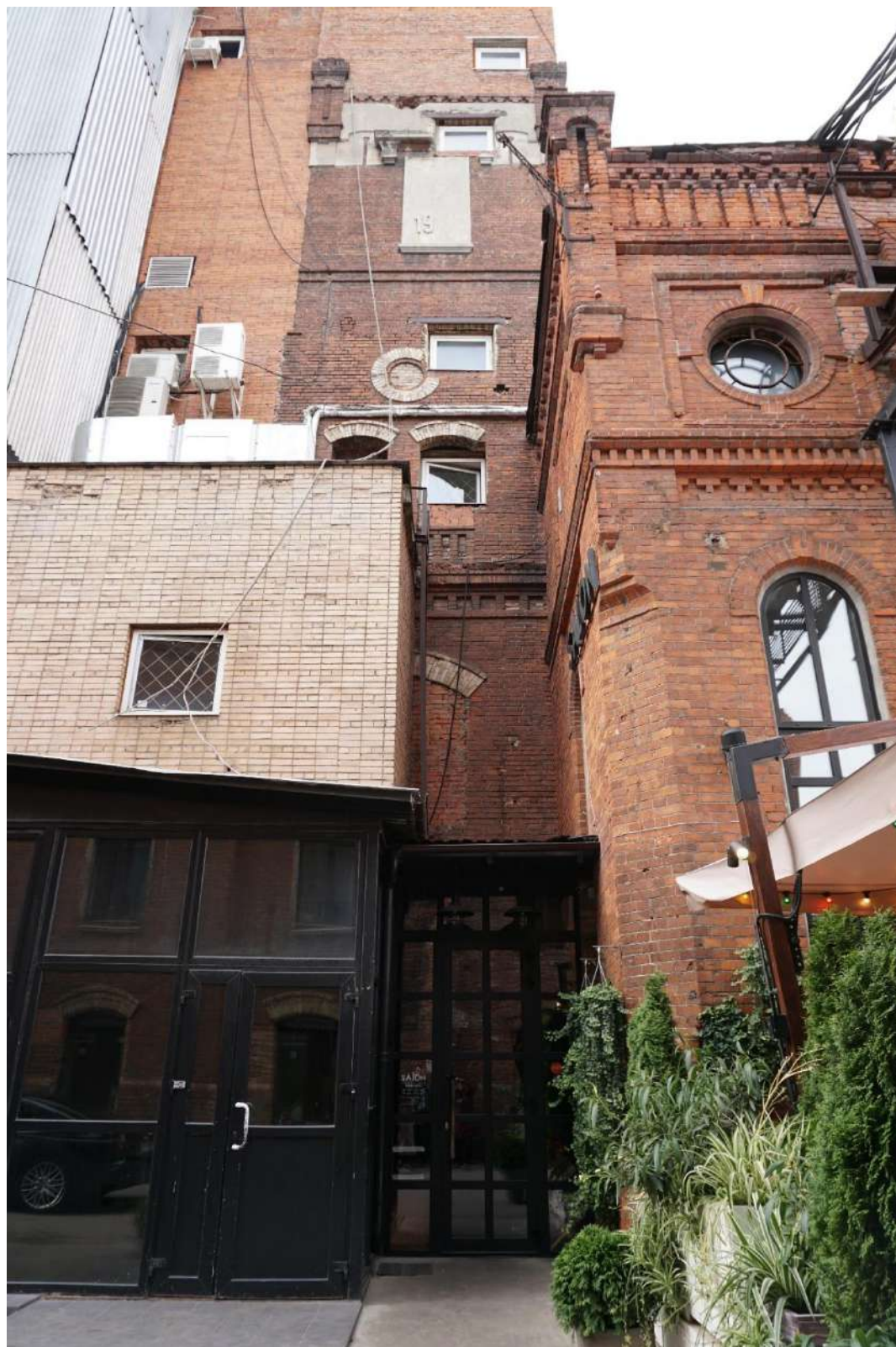
Рис. 31. Более темный и мелкий кирпич – кладка XIX века. Видны также частично заложённые окна и элементы декора. Фотография сделана ок. 2021 г.
