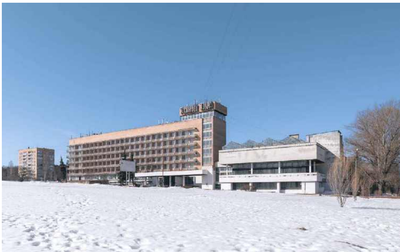
4.17. Гостиница с рестораном в Пущине
