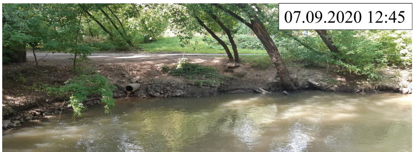
Рисунок 3.3. Сброс сточных вод с повышенной мутностью в р. Сетунь 07.09.2020 г.
