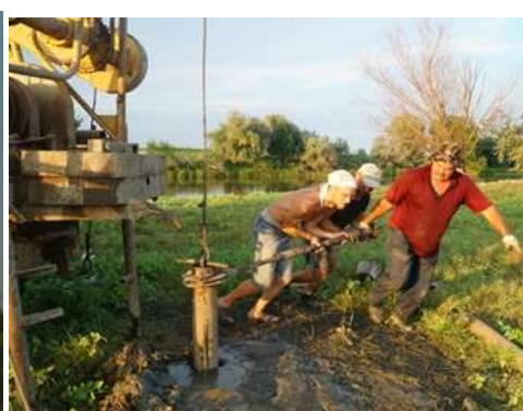
Рисунок 26. Бурение скважины Роу-2016 (пос. Пойменный). а), б) фрагменты полученного керна; в) буровая установка, г) процесс бурения. (Фото Р.Н. Курбанова).
