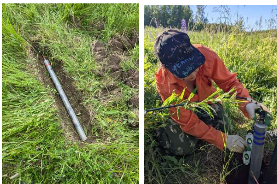
Рисунок 21 – Процесс установки индукционных датчиков IMS-010
