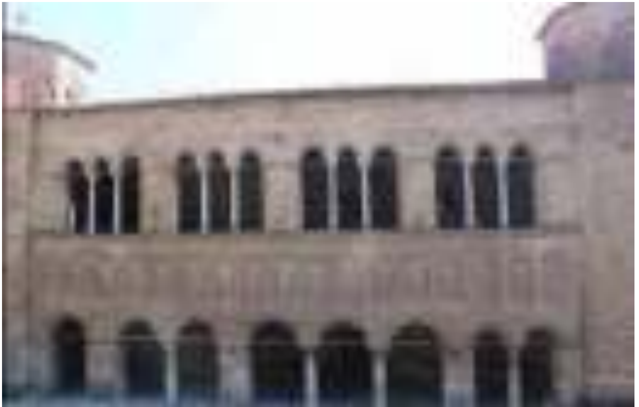
146. Охрид. Экзонартекс собора Св. Софии. 1313/1314 г. Западный фасад. Фото автора. 2020 г.
