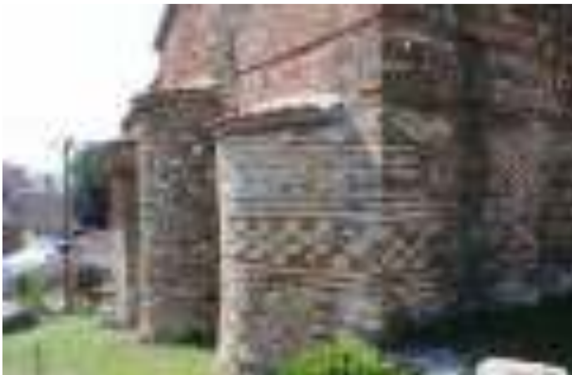
173. Прилеп. Церковь Св. Димитрия. XII в. – 1290-е гг. Вид северо-востока. Северная апсида и угол впоследствии заложеного портика. Фото автора. 2020 г.
