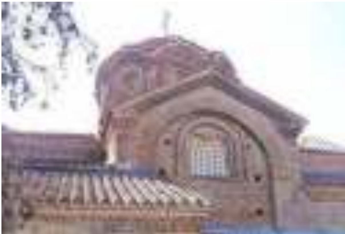
139. Охрид. Церковь Богородицы Перивлепты. 1294/1295 г. Северный фасад. Фрагмент. Фото автора. 2020 г.
