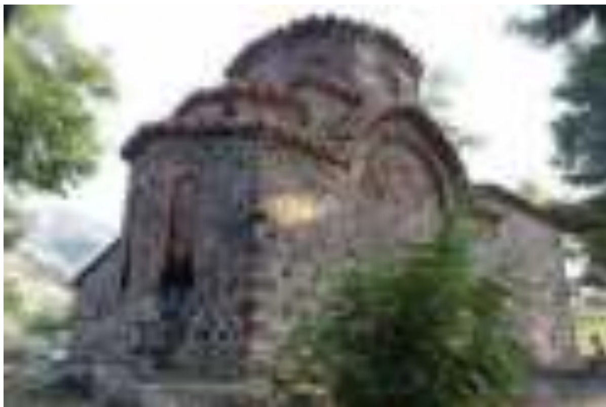
130. Борье близ Корче, Албания. Церковь Св. Спаса. Ок. кон. XIII–нач. XIV в. Вид с северо-востока. Фото А. В. Захаровой. 2019 г.
