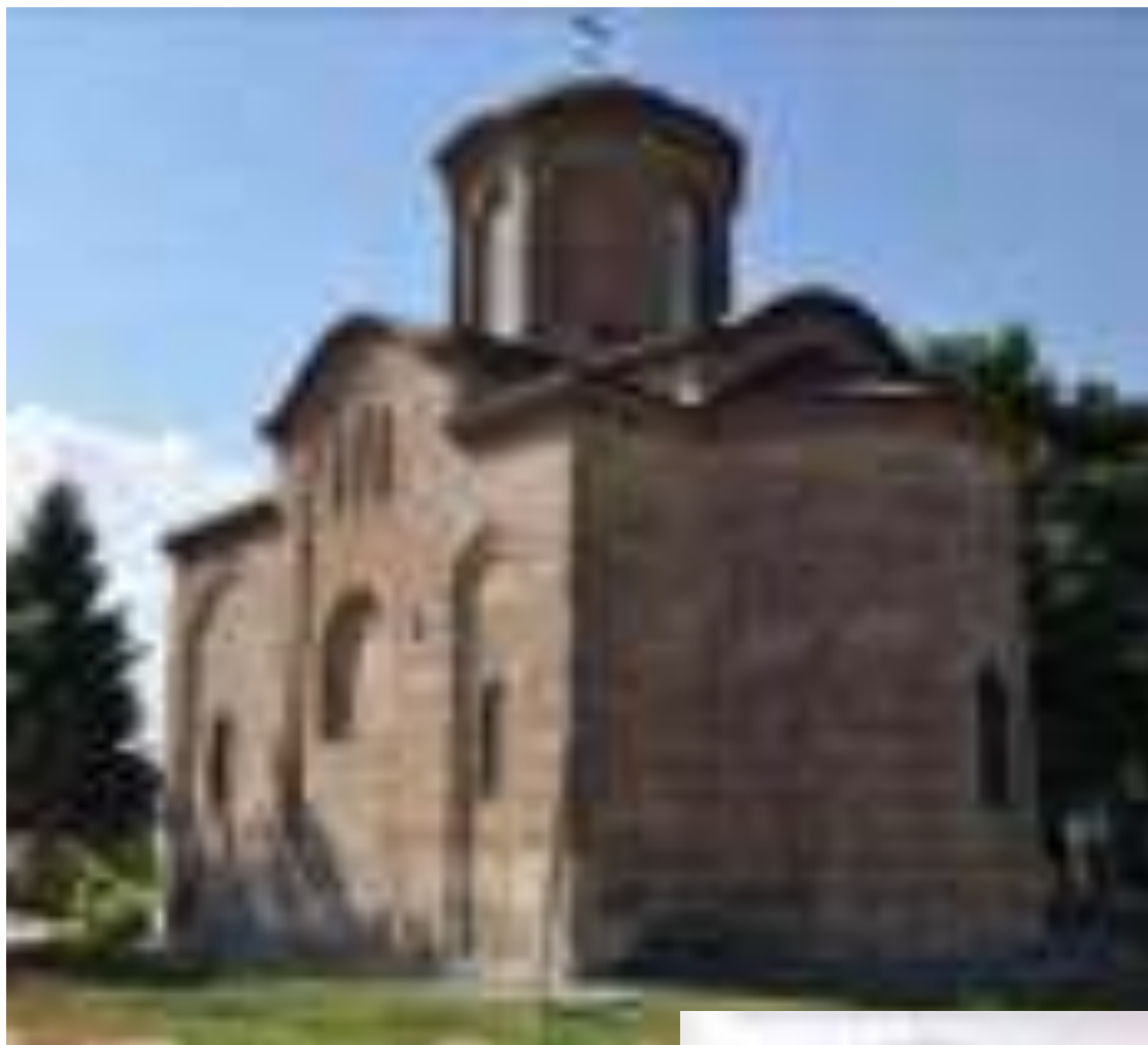
323. Люботен. Церковь Св. Николая. 1337 г. Вид с юго-востока. Фото автора. 2020 г.
