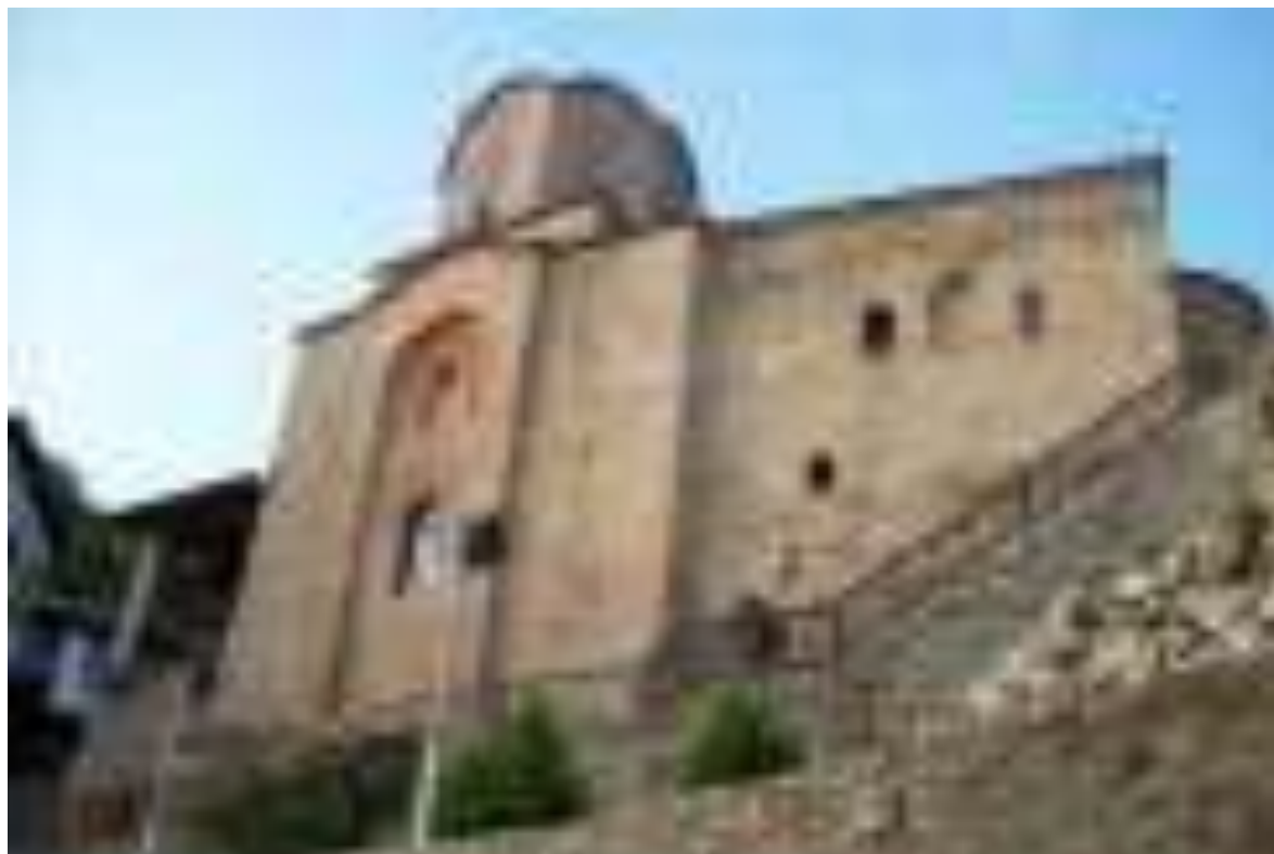
184. Прилеп. Церковь Св. Архангела Михаила. 1270–1280-е гг. в. Вид с юго-востока. Фото автора. 2020 г.
