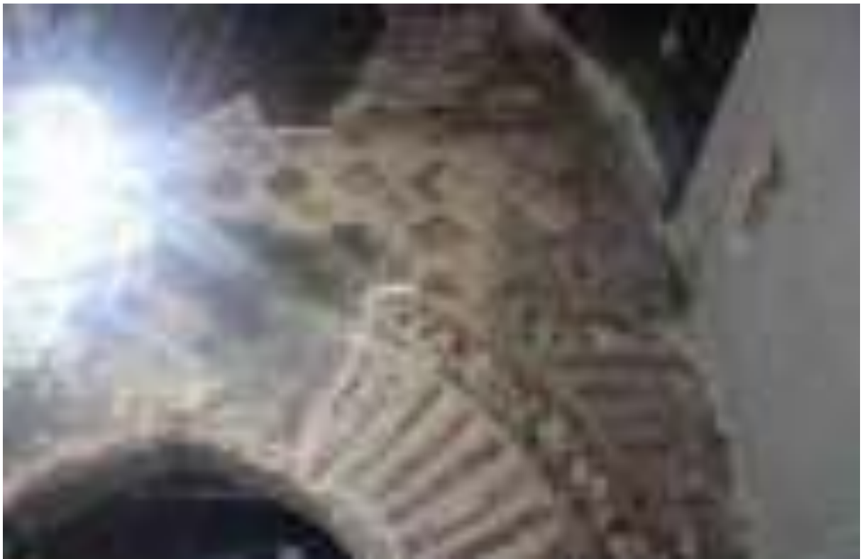
166. Велес. Церковь Св. Димитрия. 1297 г. Западная стена основного объема, вид из нартекса. Фрагмент (предыдущая строительная фаза). Opus reticulatum. Фото автора. 2020 г.
