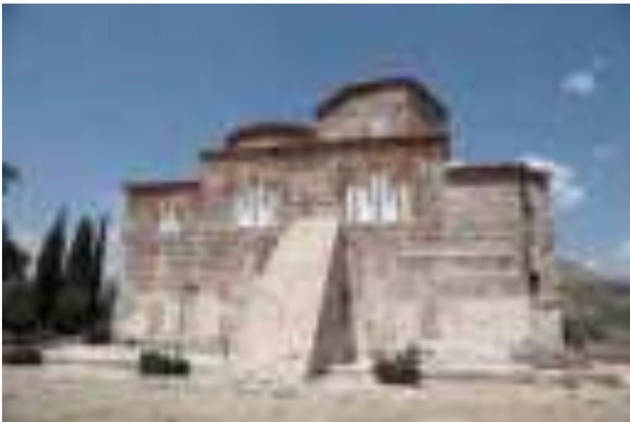
45. Месопотам, Албания. Церковь Св. Николая. Первая четв. XIII в. (по К. Гиакумису и Г. Карайскаю). Вид с юга. Фото А. В. Захаровой. 2019 г.
