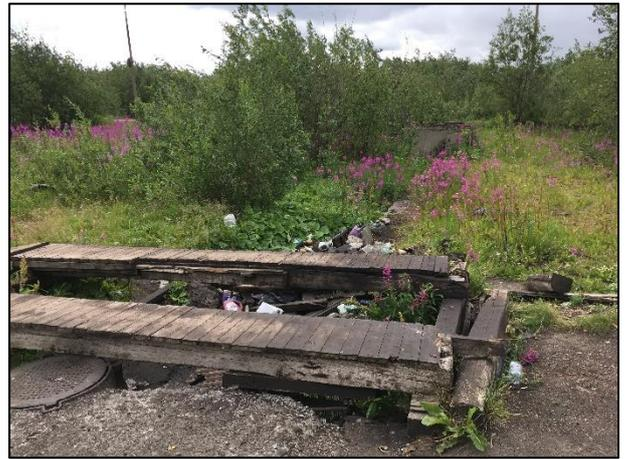
*Рис.5.12. Просадка грунта вокруг коллектора санитарно-технических коммуникаций. (фотография автора, август 2018 г.)*
