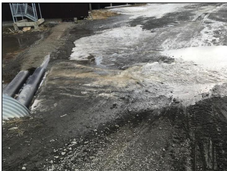
*Рис. 5.2. Водопропускная труба, совмещенная с пропуском санитарно-технических коммуникаций под насыпью дороги в г. Лонгйир (фотография автора, май 2018 г.)*
