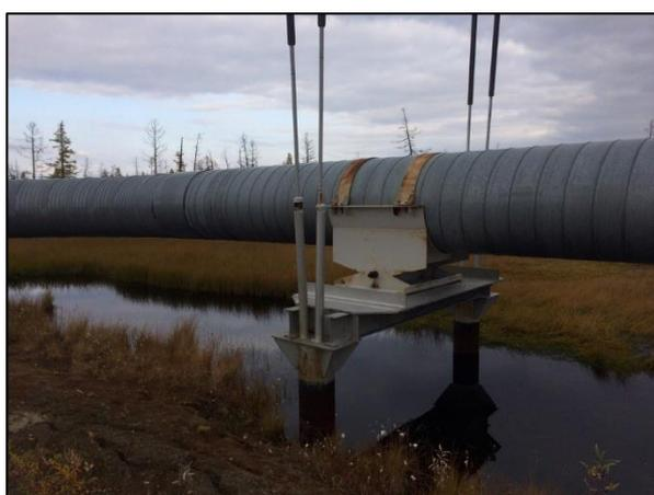
*Рис. 5.20. Подтопление опорной конструкции МНП (фотография автора, сентябрь 2017 г.)*
