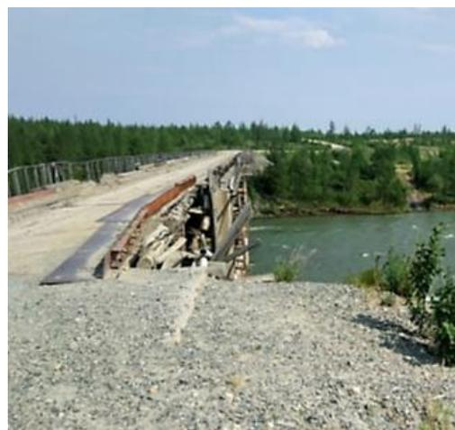
*Рис. 5.17 Аварийный мостовой переход через р. Харбей (фотография В.А. Федина)*
