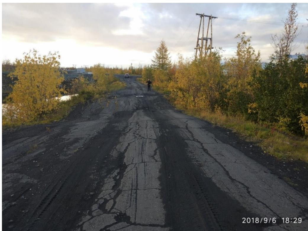
*Рис.5.27. Волнообразные просадки дороги к санаторию «Валёк» при вытаивании ледяных тел в грунтовом основании (фотография Толманова В., сентябрь 2018 г)*
