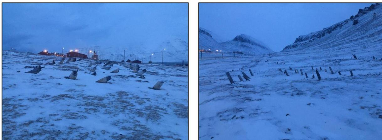
Рис. 5.7. «Пьяные» сваи на склоне в г. Лонгйир – результат действия солифлюкции (фотография автора)
