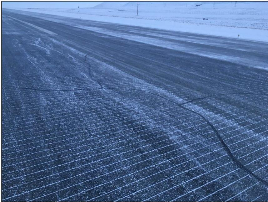
Рис. 5.5. Морозобойные трещины на поверхности ВПП (фотография автора)
