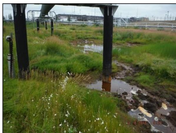
*Рис. 5.21. Развитие эрозии в непосредственной близости от опор МНП (фотография автора, июль 2017 г.)*
