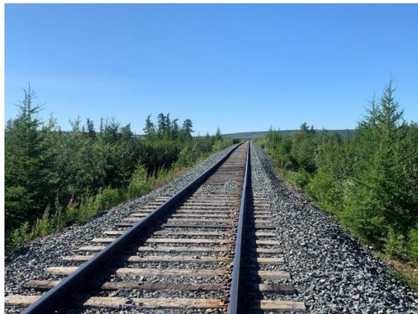
*Рис. 5.15 Волнообразные деформации на железной дороге Обская-Бованенково в районе р. Щучья (фотография автора)*
