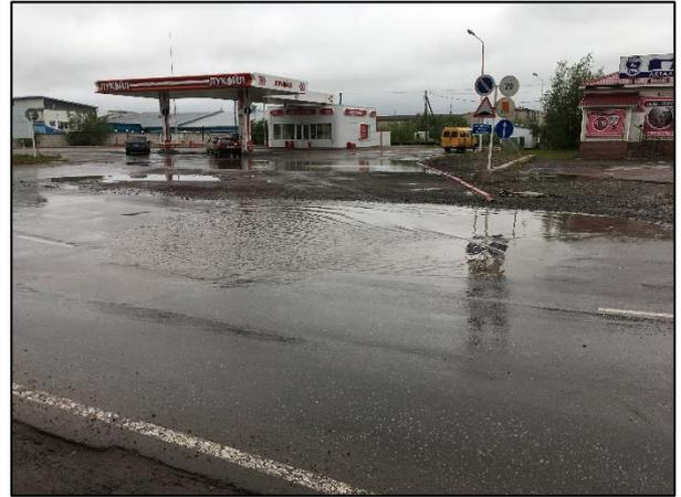
*Рис.5.9. Просадки дорожного покрытия на бул. Пищевиков, г Воркута (фотографии автора, август 2018 г.)*
