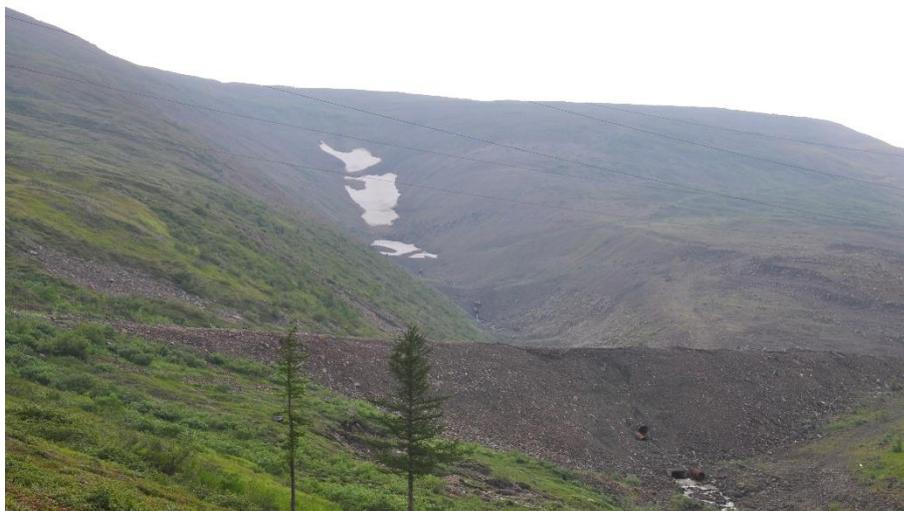
*Рис.5.25 Лавинный очаг в районе Талнаха, перекрытый лавинозащитной дамбой
