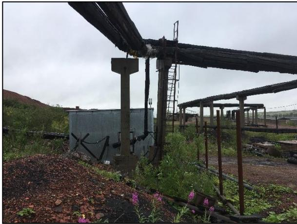
*Рис.5.11. Просадка опоры трубопровода в районе шахты Воркутинская (фотография автора, август 2018 г.)*
