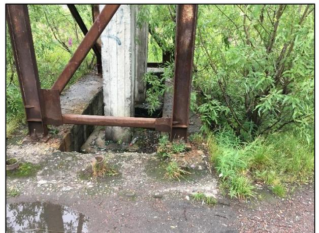
*Рис.5.10. Просадка опоры надземного трубопровода на бул. Пищевиков (фотографии автора, август 2018 г.)*
