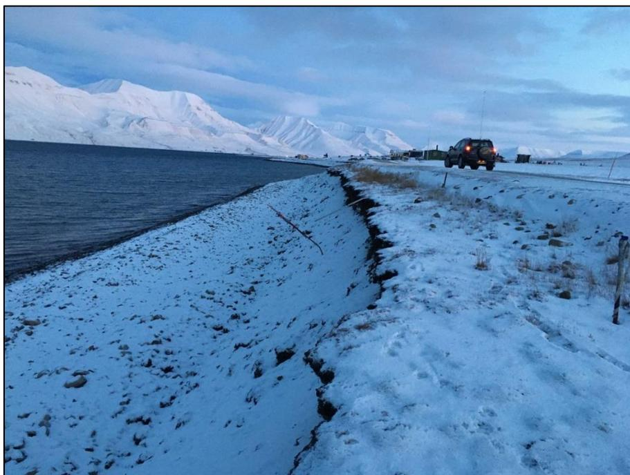
*Рис. 5.8. Разрушение берега в результате действия процесса термоабразии, г. Лонгйир (фотография автора)*
