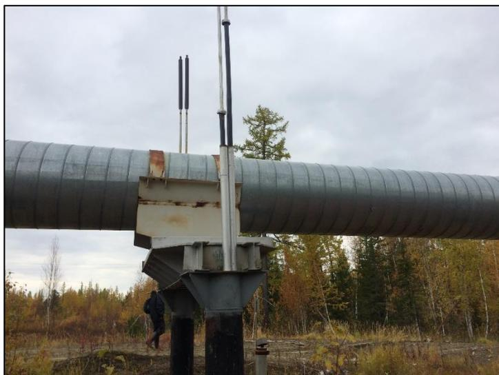
*Рис.5.23. Выпучивание COY и разрыв защитных гильз термостабилизаторов на трассе МНП (фотография автора, сентябрь 2017 г.)*
