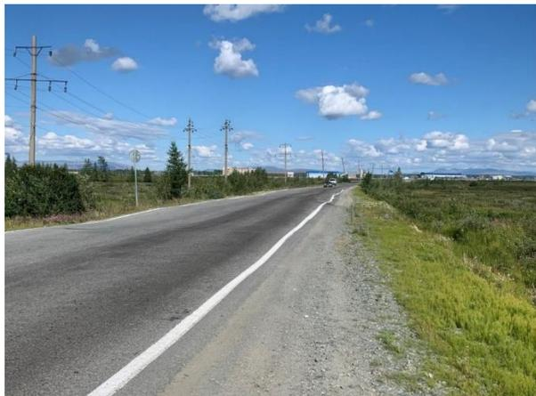
*Рис. 5.14 Волнообразные деформации на дороге Лабитнанги-станция Обская (фотография автора)*
