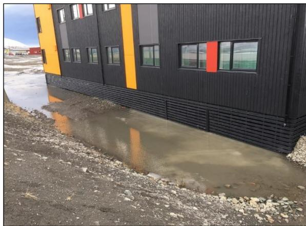
*Рис. 5.1 Подтопление вдоль насыпей дорог на Шпицбергене, вызванное недостаточной проработанностью водопропускных сооружений (фотографии автора, май 2018 г.)*
