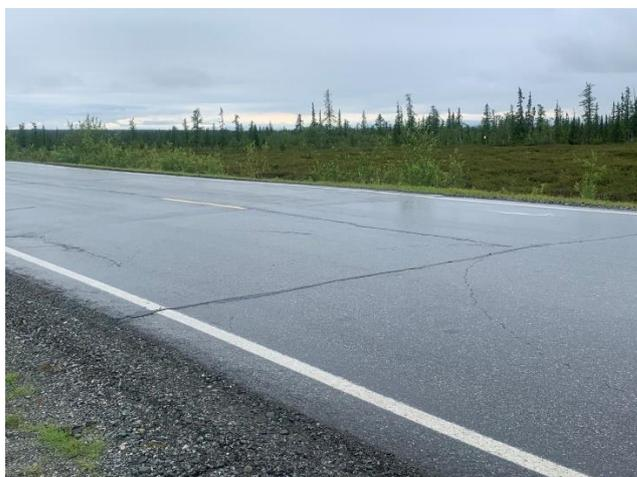
*Рис. 5.16 Растрескивание дорожного покрытия на дороге Салехард-Аксарка (фотография автора)*
