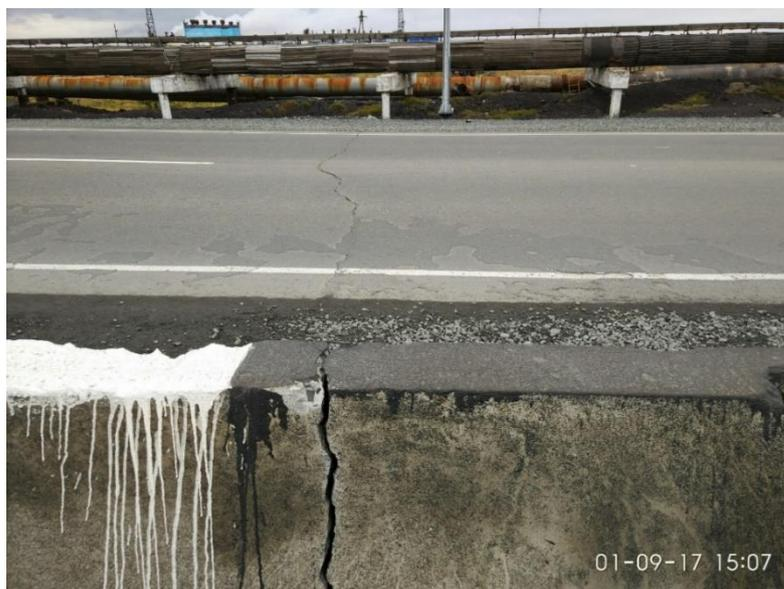
*Рис.5.26. Образование морозобойной трещины на дорожном полотне в
