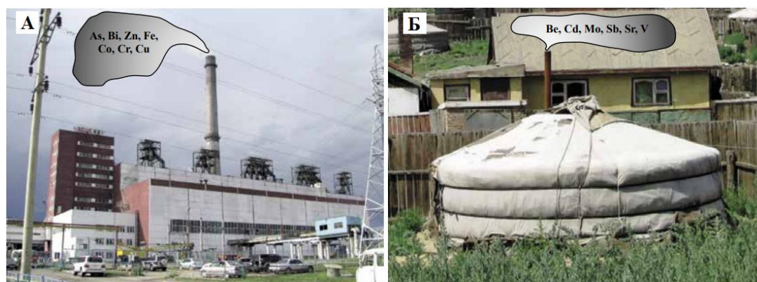
Рис. 3. Геохимическая специализация выбросов топливной энергетики: А – ТЭЦ ( h = 120 м), высокая температура горения; Б – юрты ( h = 3 м), низкая температура горения (Сорокина, 2013)
