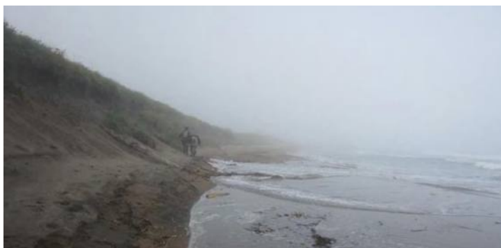
Рисунок 3.2.33. Антропогенно спровоцированный размыв аккумулятивного берега в заливе Щукина (о. Уруп) в 2 км к югу от техногенного прохода в отмостке (фото автора)
