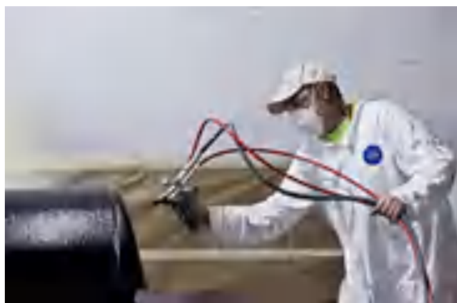
Рисунок 1.5 – Нанесение антикоррозионного покрытия марки EonCoat [45] на основе MgKPO_4 \cdot 6H_2O
