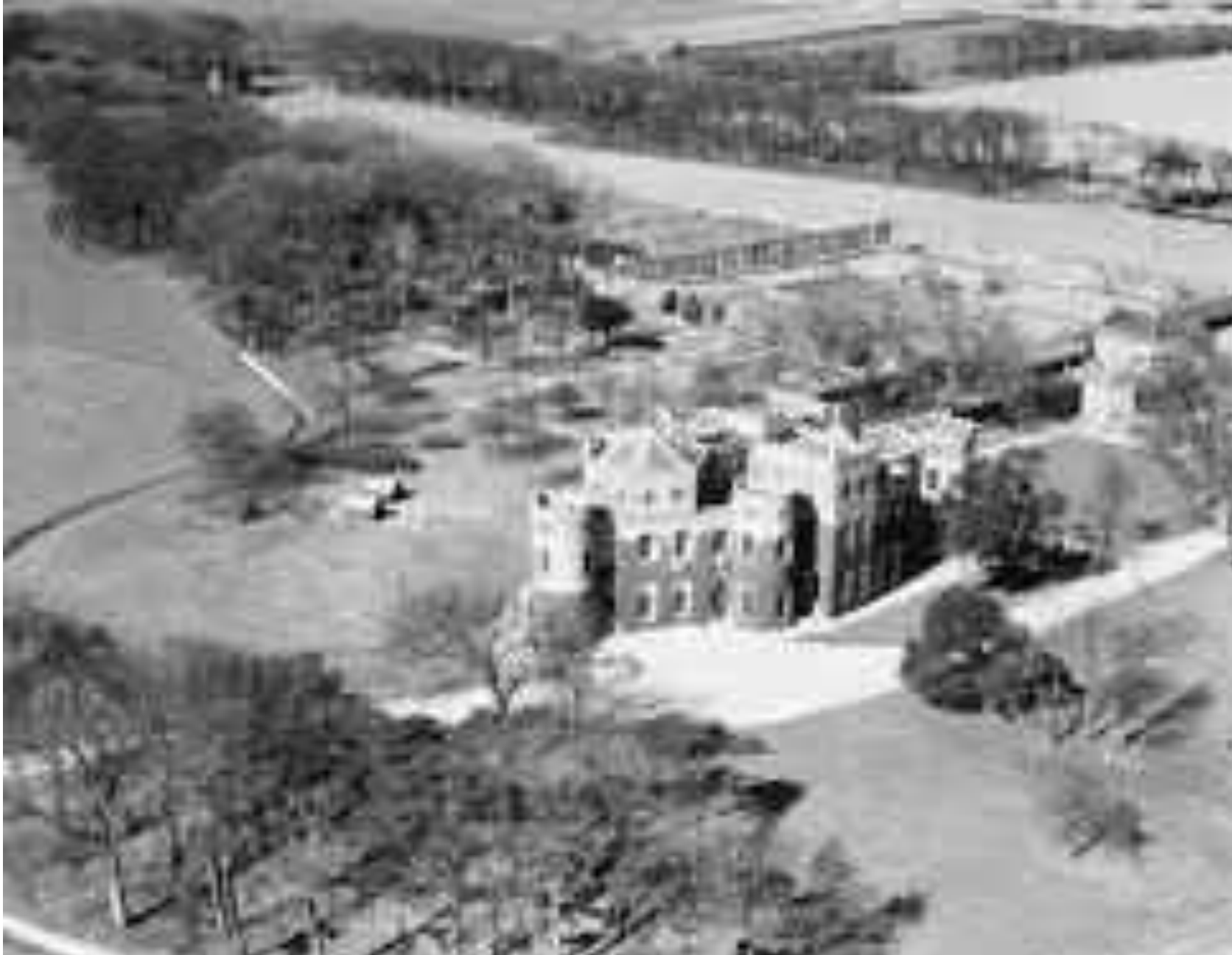
20. Карр Дж. Главный дом в Гримстон Гарр. 1780-е. Общий вид..
