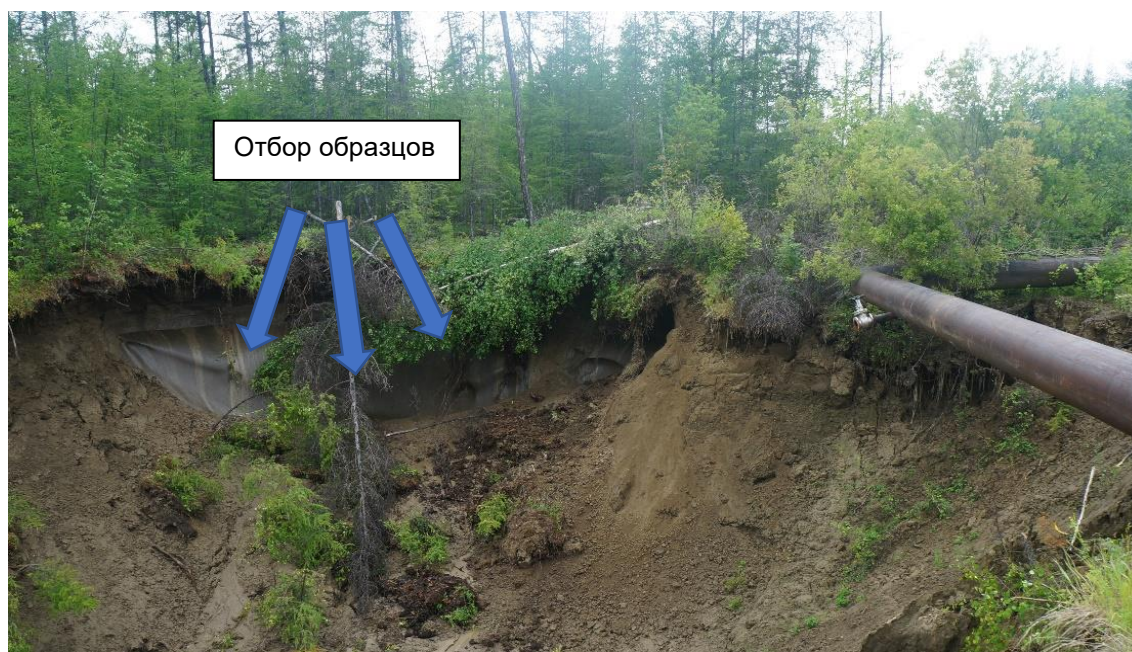
Рис. 4.4. Термоэрозионный овраг, выходы подземного льда в районе оз. Сырдах, 2017 г.
