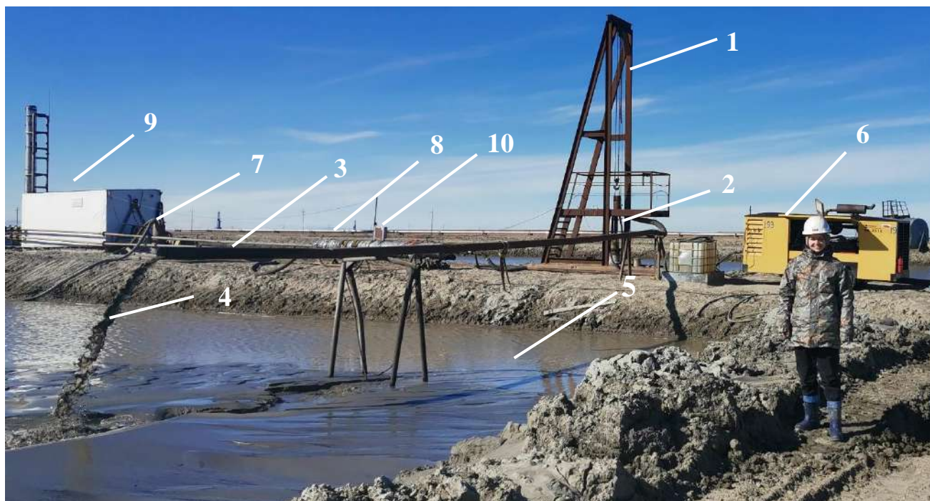
Рис. 130. Фрагмент площадки строительства подземных резервуаров для захоронения отходов бурения (фото автора): 1 – мачта, 2 – скважина, 3 – пульпопроводная труба, 4 – пульпа, 5 – гидроотвал (карта намыва), 6 – компрессор, 7– насос, 8 – теплообменник, 9 – котельная, 10 – щиток управления (пояснения см. в тексте).
