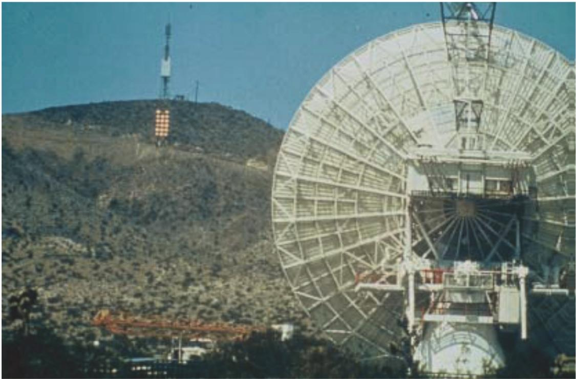
Рис. 1.3. Антенна радиотелескопа обсерватории Голдстоун передает микроволновое излучение на ректенную решетку (1975 г.) [72].
