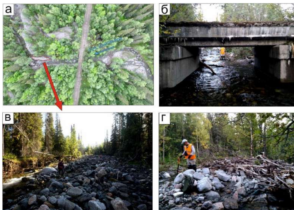
Рис. 5.10 Вид на зону разгрузки бассейна руч.Сенгисйока в створе железной дороги Ревда-Октябрьский (съемка с помощью БПЛА выполнена В.Р.Беляевым): б - водопропускное сооружение в теле железнодорожной насыпи и сформировавшееся в результате концентрации потока нагромождение валунов (в,г); б, г – фото автора; в – фото В.Р. Беляева
