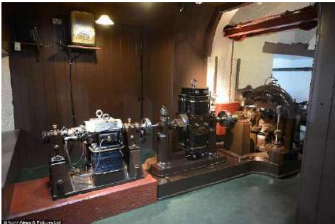
Илл. IV-69. Электрический генератор в усадебном доме Крэгсайд (Cragside), Беркшир, 1869-95 гг., арх. Ричард Норман Шоу.
