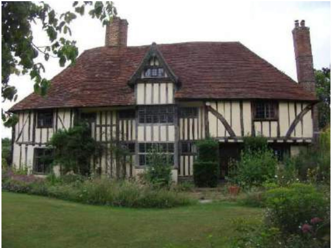
IV-108. Пример фахверковой архитектуры графств Сассекс и Кент: сельский дом типологии «Wealden Hall House» (XIV-XVI вв.)
