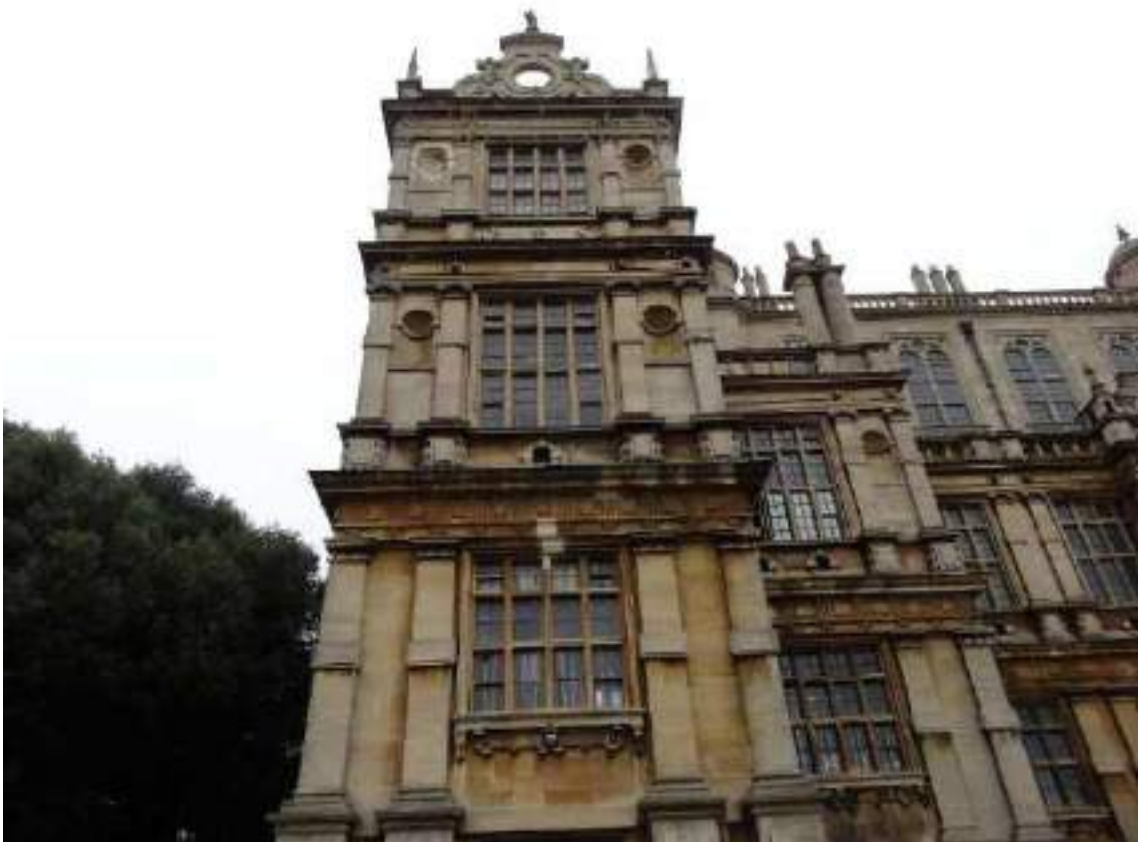
Илл. I-42. Уоллатон-холл: угловая башня. Фото автора.
