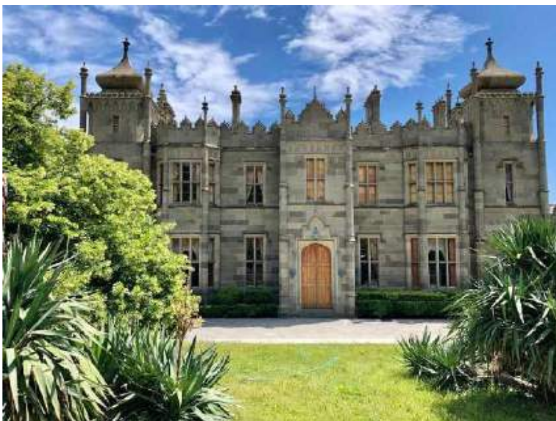
Илл. III-27. Эдвард Блор. Воронцовский дворец в Алушке, Крым. Главный корпус. 1832-41 гг.
