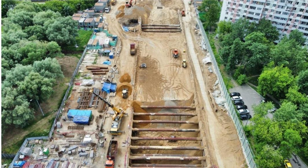
Рисунок 5.2. Процесс обратной засыпки котлована оборотных тупиков, ст. Кленовый бульвар, Большая кольцевая линия (фото «Развитие Метрополитена и Транспорта в Москве»<sup>4</sup>)
