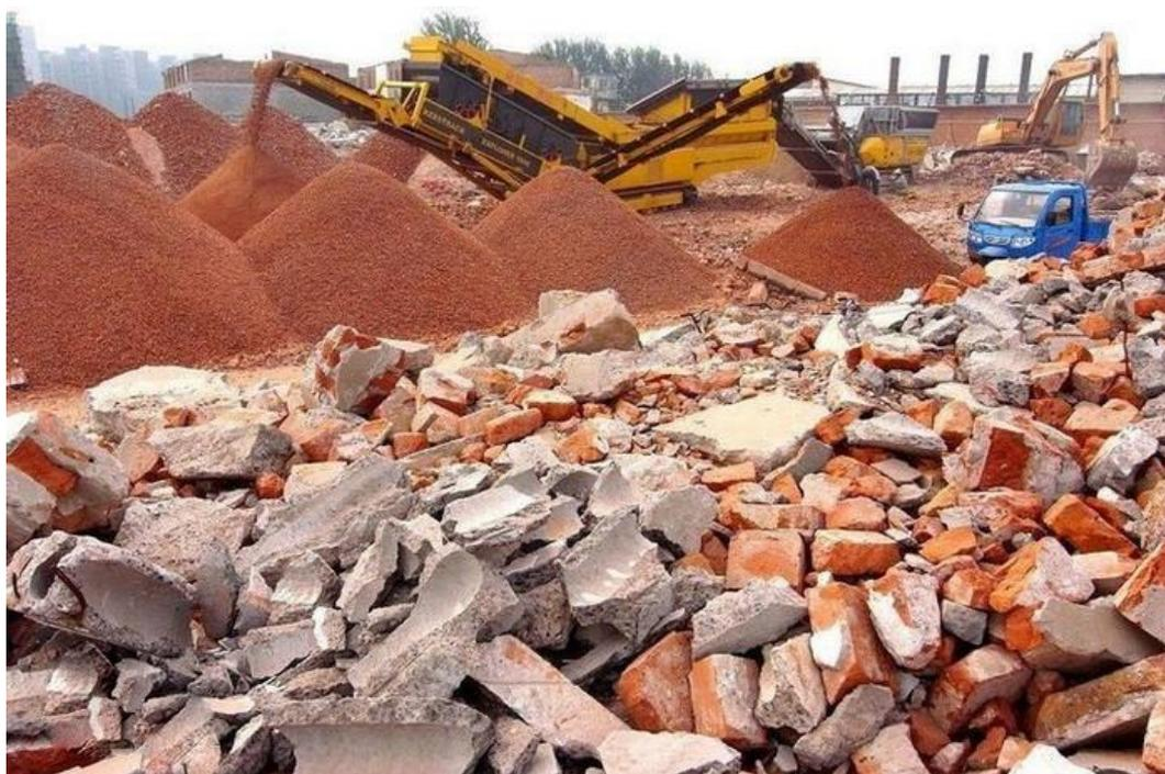
Рисунок 5.6. Процесс дробления отходов сноса с целью вторичного использования [143]
