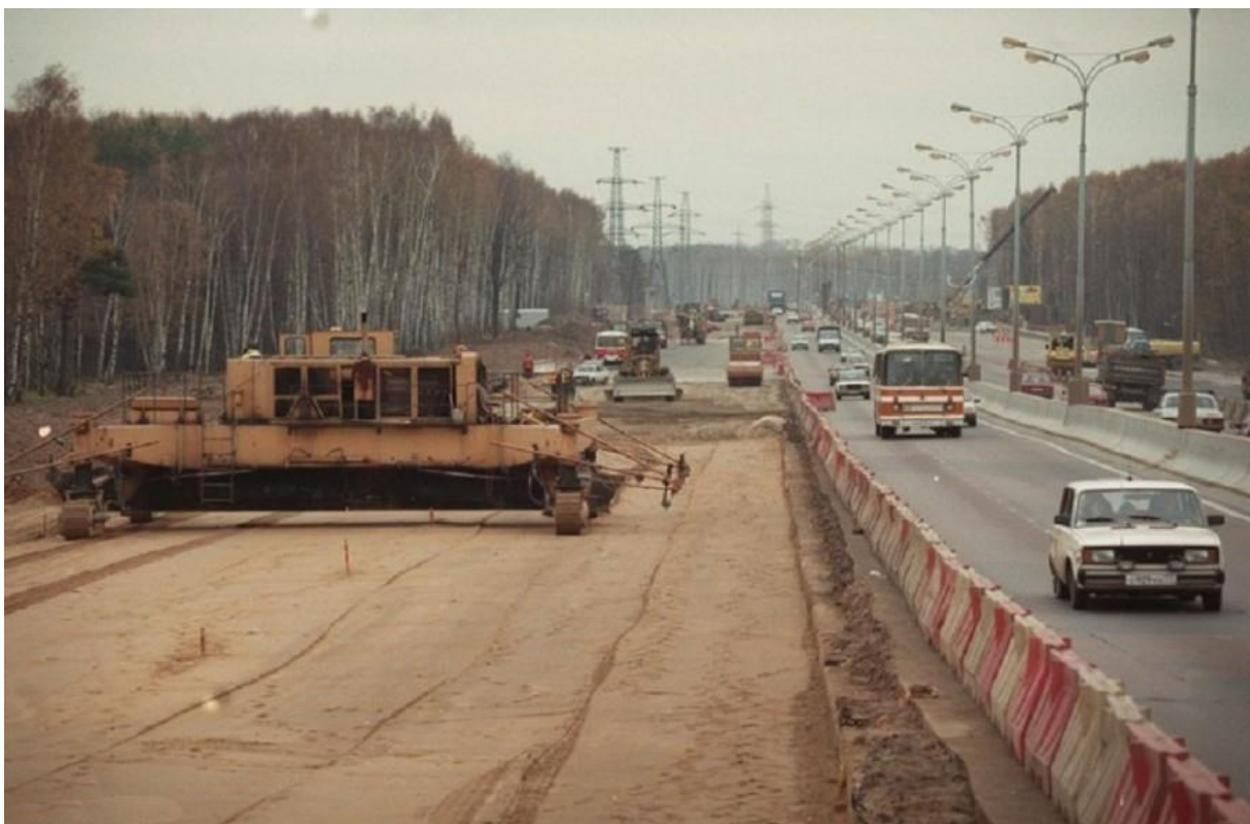
Рисунок 5.1. Процесс укладки земляного полотна при реконструкции МКАД, 1997 г. (фото ИТАР-ТАСС)
