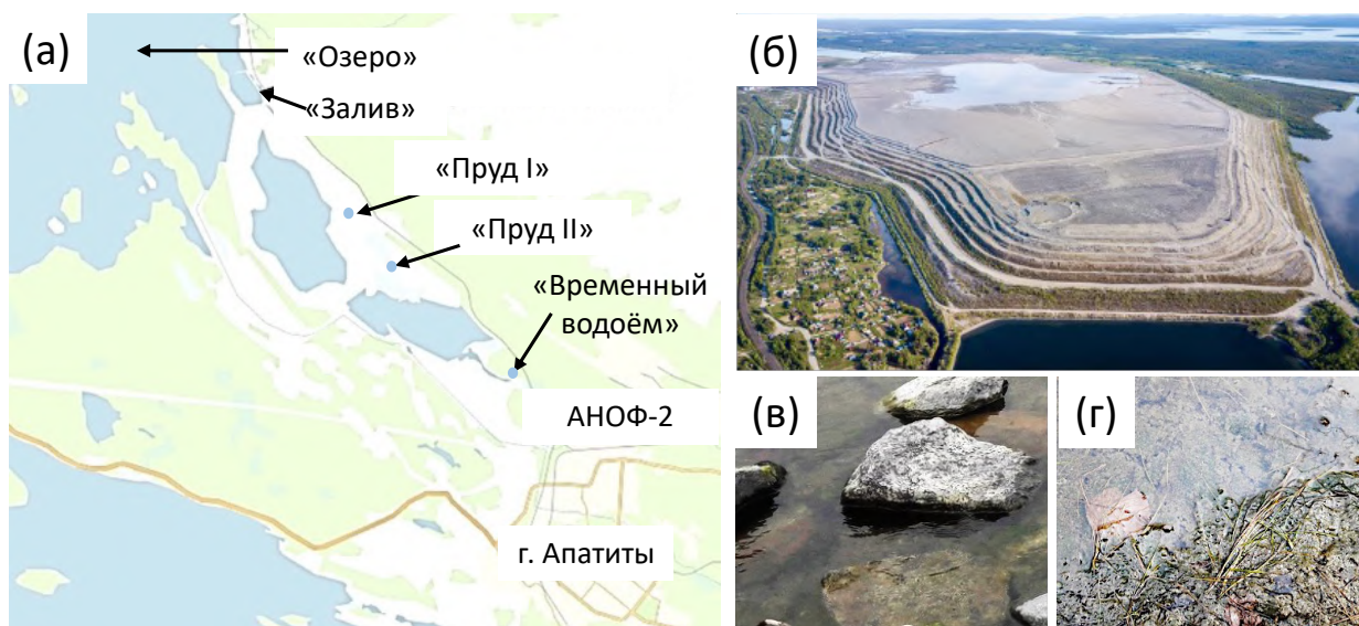
Рис. 7. АБС апатитовых разработок: карта расположения водоёмов и точек пробоотбора АБС (а), общий вид апатит-нефелинового карьера и хвостохранилища АНОФ-2 с водоёмами вокруг него (б), вид берега озера Б. Имандра с флоккулами и обрастаниями АБС (в), вид берега прудов с флоккулами АБС (г).
