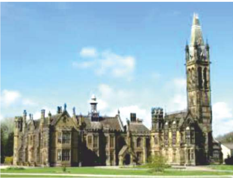
61. Скэрисбрик Холл, Ланкашир (Scarisbrick Hall, Lancashire, 1837-1845, арх. О.Пьюджин).
